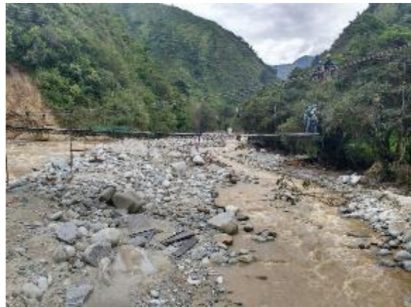
Instalación de vigas y piso para puente peatonal
