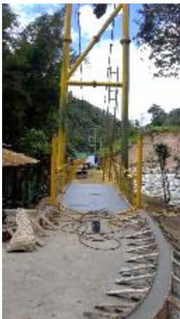
Construcción de acceso peatonal en concreto
