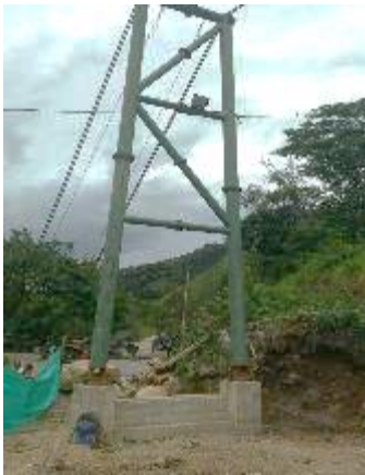
Construcción de muro en concreto y pórticos
