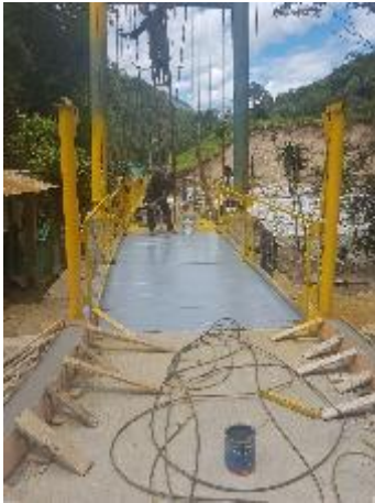
Instalación de barandas y pintura de piso
