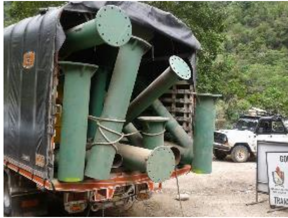
Construcción de pórticos
