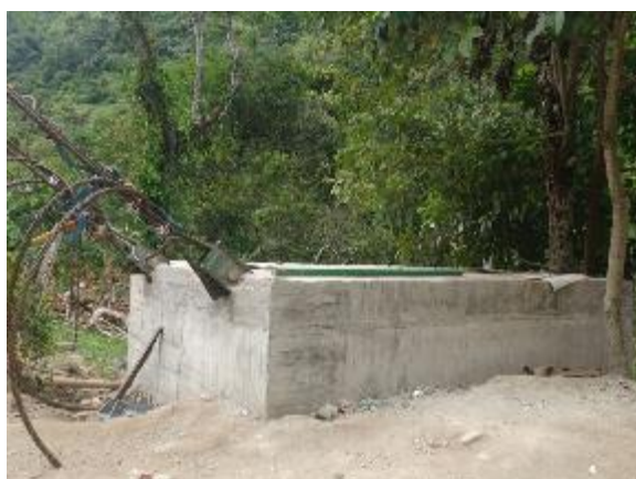
Construcción de macizos de anclaje
