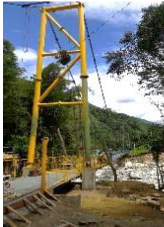
Pintura de pórticos y barandas del puente peatonal
