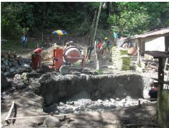
Construcción de cimentación en concreto ciclopeo
