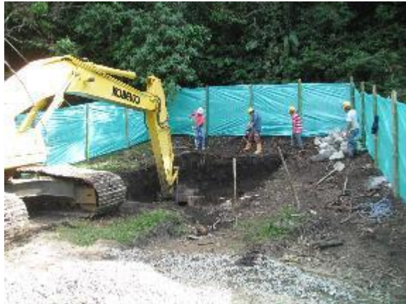
Excavación para cimentación
