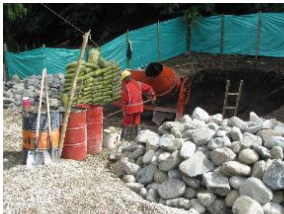
Construcción de cimentación en concreto ciclopeo
