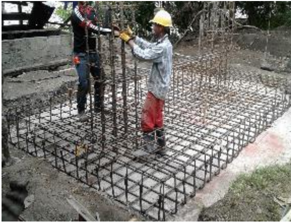
Construcción de muro en concreto reforzado
